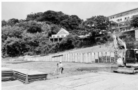
坂道の土留め工事
